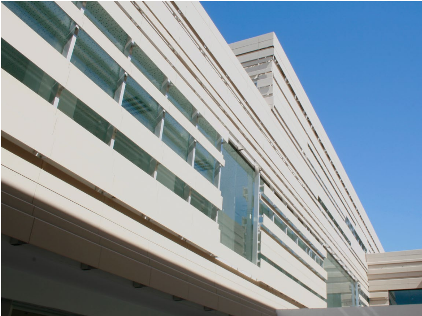
Health Centre, Distrito Sur. Jerez de la Frontera, Spain.
